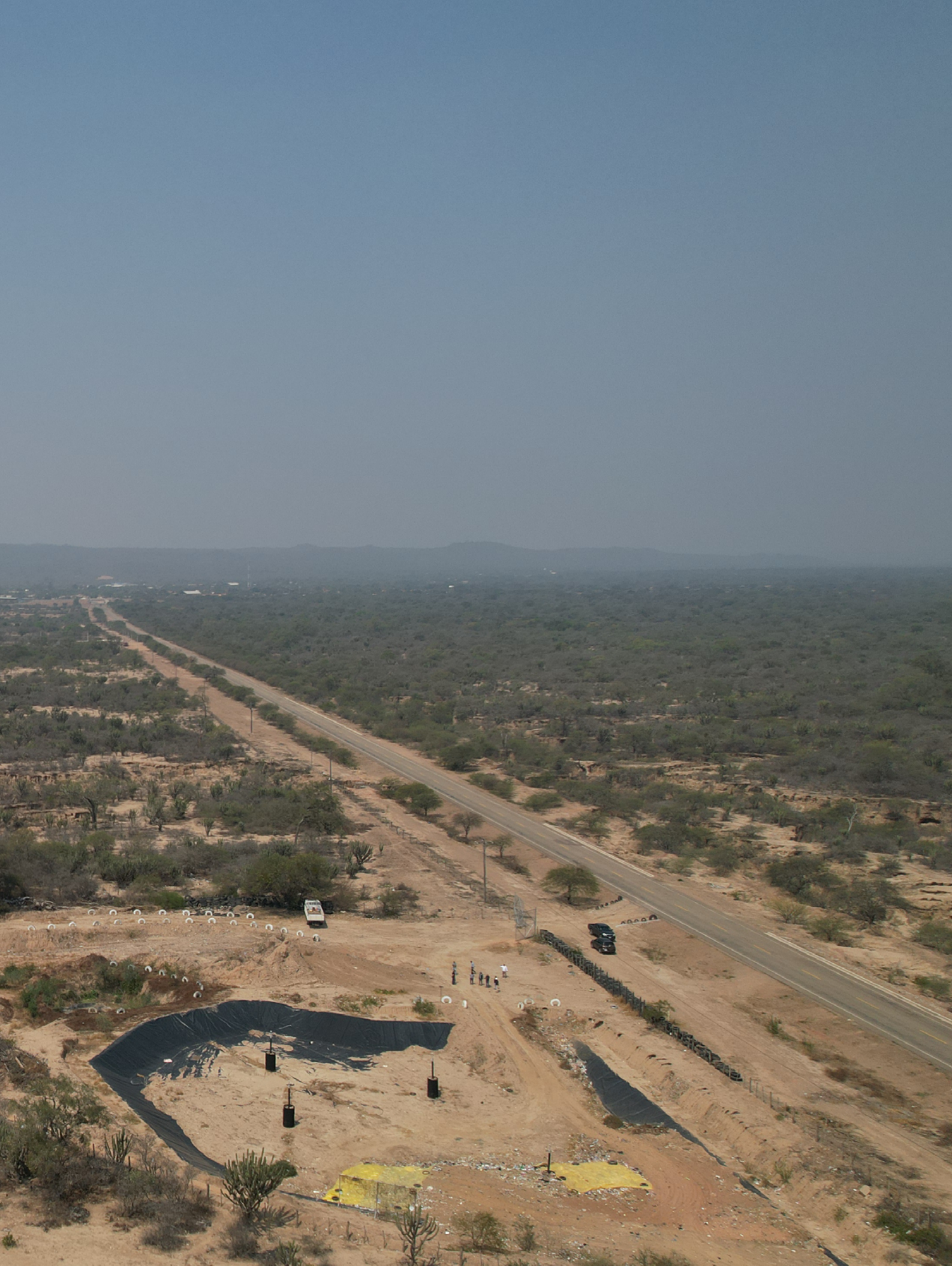
Macrocela de residuos en el botadero rehabilitado a relleno sanitario - municipio Boyuibe, Helvetas, 2024
