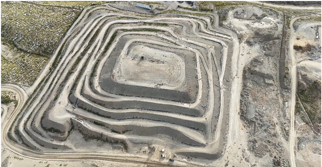
Figura 4. Macrocela clausurada en el relleno sanitario de Villa Ingenio, El Alto.
